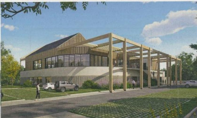
Le bâtiment sera réalisé en béton et bois. L'ensemble de l'étage sera habillé de bois, avec un bardage posé verticalement.
